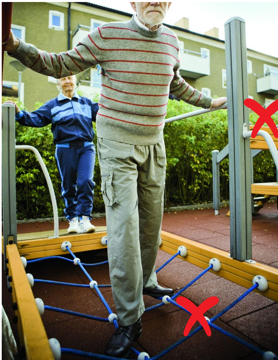
מאחז יד קצר ורחב מידי משטח דריכה לא בטוח
