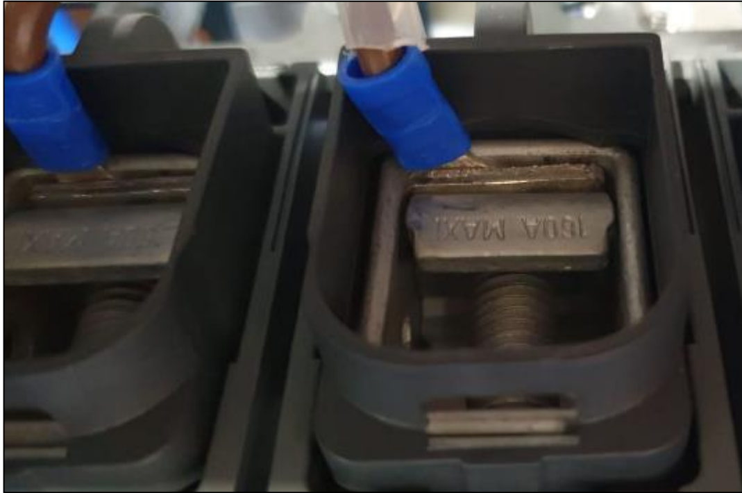
פתרון יצירתי – חיבור מוליך פיקוד במחבר מהיר ABB FC , מאחורי הפלטה
