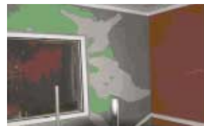
תמונה מס' 7 - שיחון טיח ממישור הרשת בהשפעת הדף
